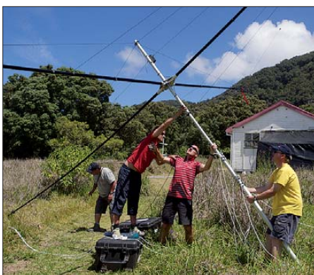
Antennenbau ist Teamarbeit: Zusammenbau eines Spider-Beams
